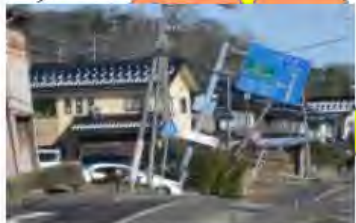
内灘町西荒屋地内（液状化）
