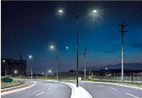
【道路照明のLED化】
