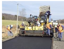
低炭素アスファルト (CO2排出量7～18%削減)
