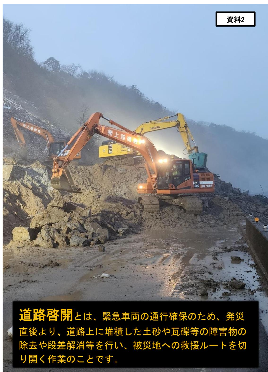
**道路啓開**とは、緊急車両の通行確保のため、発災直後より、道路上に堆積した土砂や瓦礫等の障害物の除去や段差解消等を行い、被災地への救援ルートを切り開く作業のことです。
