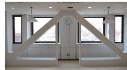
ブレース補強工法
