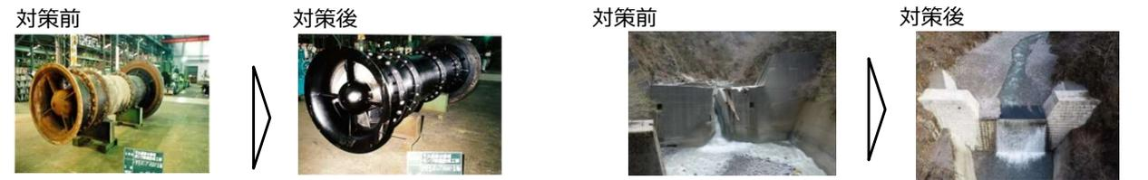
老朽化したポンプ設備の修繕・更新により、災害のリスクを軽減
