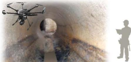
例：管路内部のドローン調査のイメージ
