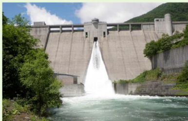
札内川ダムのフラッシュ放流
