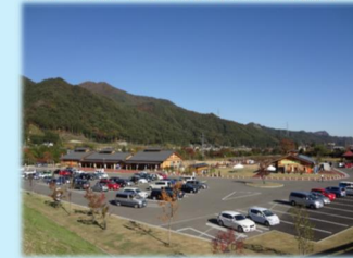
交流施設の整備(ハツ場ダム)
