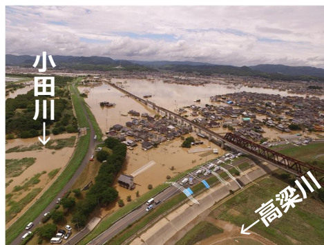
平成30年 高梁川水系小田川（岡山県倉敷市）
