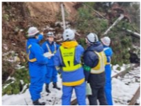
【TEC-FORCE-RAIL-FORCEによる現地調査】
