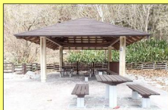
休憩舎・野外卓等の改修
