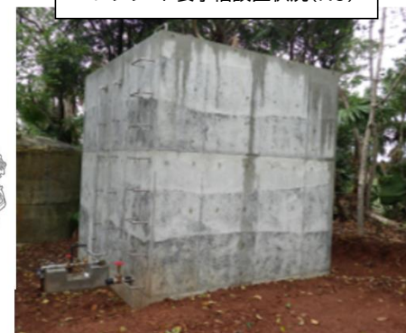
コンクリート製水槽設置状況(R6)
