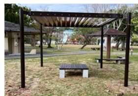
休憩施設の設置(大村中央地区)
