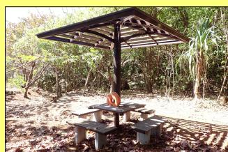
休憩舎等の改修
