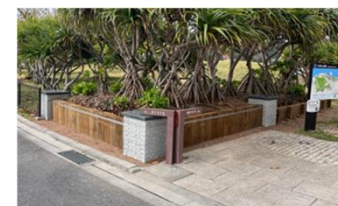
土留めの更新(大村中央地区)
