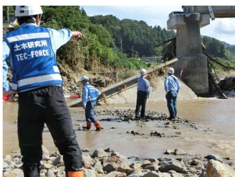
写真-1.2.1.3 被災した河川堤防の調査状況
