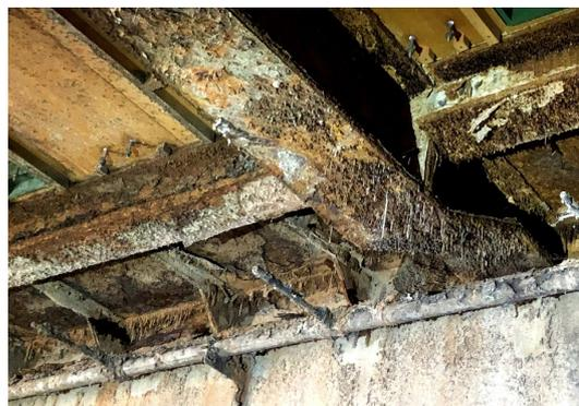
汚泥貯留槽の蓋を支える梁の腐食例
