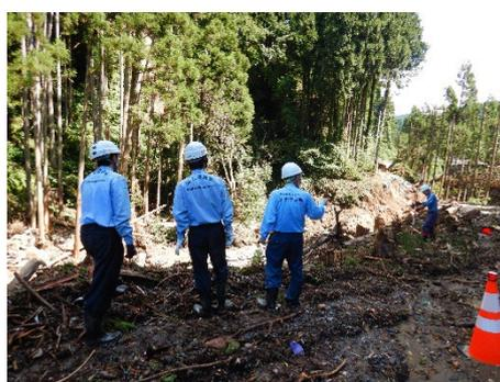
写真-1.2.1.4 中屋トンネル周辺道路の被災したのり面の調査状況
