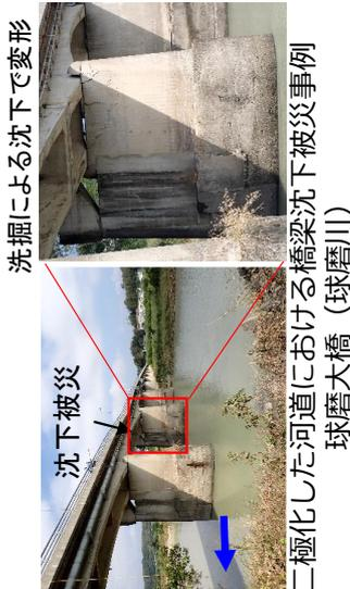
二極化した河道における橋梁沈下被災事例
