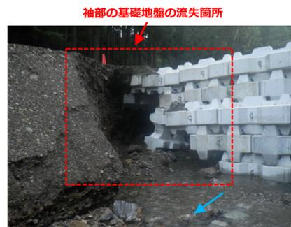
ブロック堰堤の袖部の基礎地盤流失
