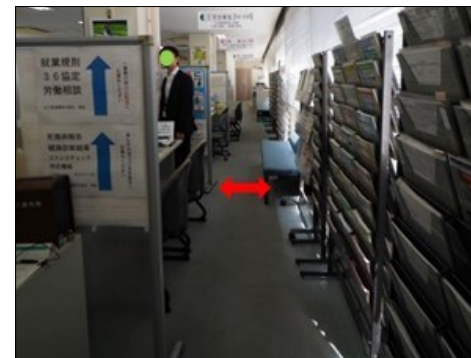
2階事務室 窓口エリアの通路が狭く、移動が困難な状態である。
