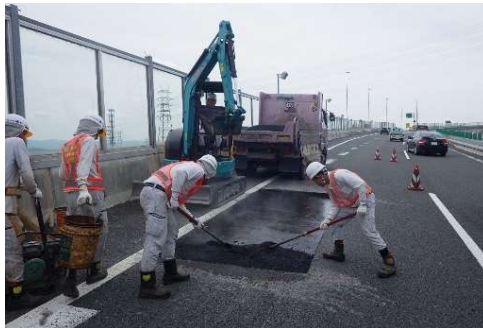
舗装の応急復旧状況
