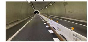
センターブロック
