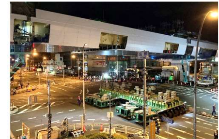
桁の架設状況
