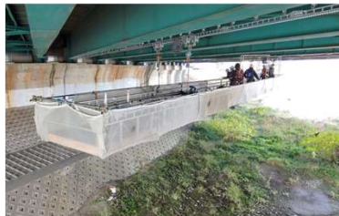
点検用の仮設足場設置(従前)
