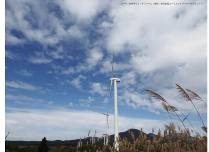
ユーラス田代平ウインドファーム(提供:株式会社ユーラスエナジーホールディングス)
