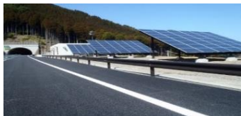
道路における太陽光発電施設活用
