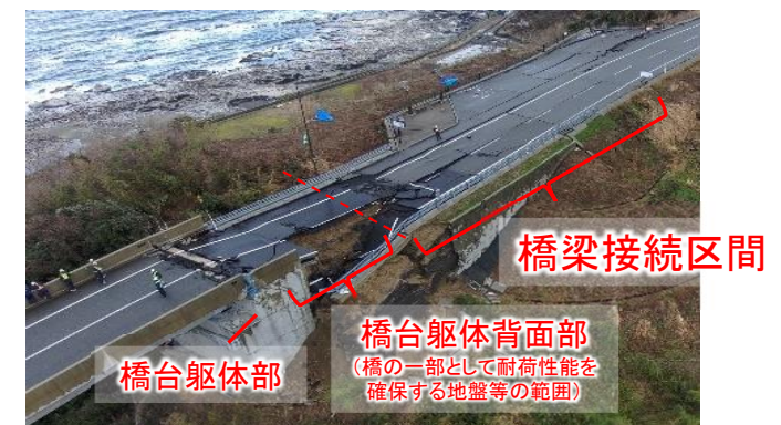
橋台躯体構造区間
