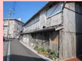
空き家の除却
