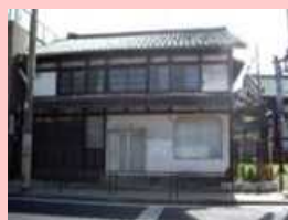
空き家の活用
