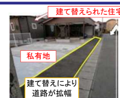
狭隘道路の解消となった例
