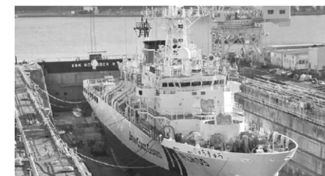
巡視船の修繕の様子 出典:佐世保重工業
