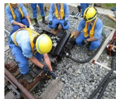
電気設備整備イメージ （転てつ機点検作業）
