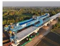
高速鉄道の高架橋工事 (写真提供：NHSRCL)
