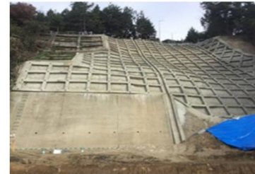
コンクリート枠による斜面の補強
