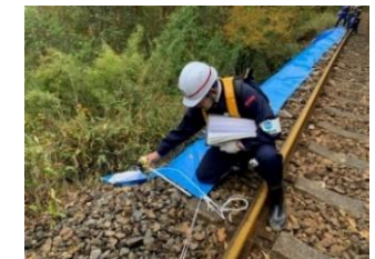
路盤の流出状況の測定
