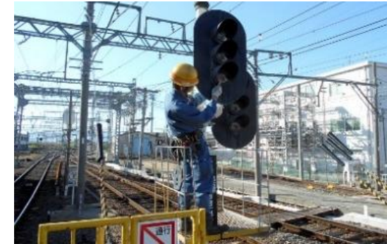
地上信号機の保守点検の様子
