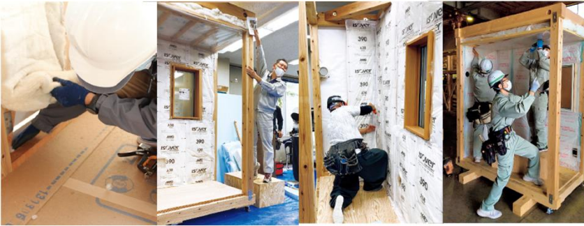
断熱施工実技研修会の様子
