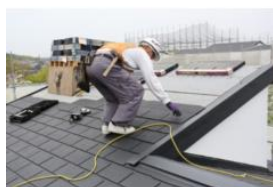
屋根の断熱化工事
