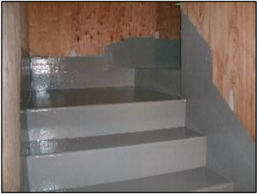
防水層及び層端部の立ち上げ
