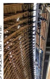
見構造+免震構造によるフレキシブルな空間（長門市庁舎）
