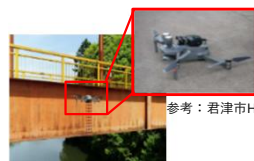
ドローンによる橋梁点検
