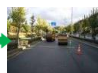
道路舗装 (表層・基層)
