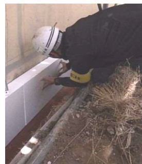
外壁の断熱化工事
