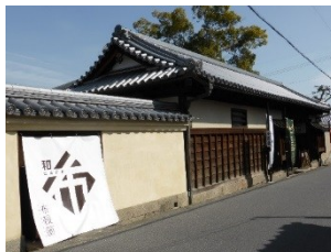
(例)歴史的建造物の修理・買取
