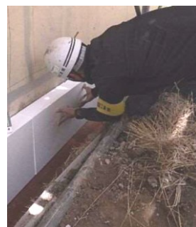
外壁の断熱化工事
