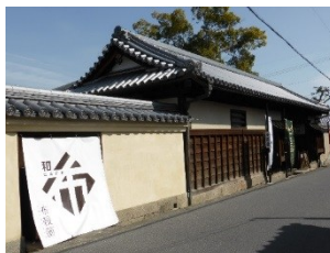
(例)歴史的建造物の修理・買取
