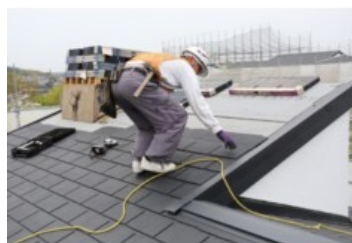
屋根の断熱化工事
