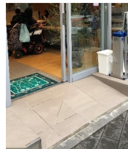
スロープの設置
