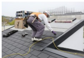
屋根の断熱化工事
