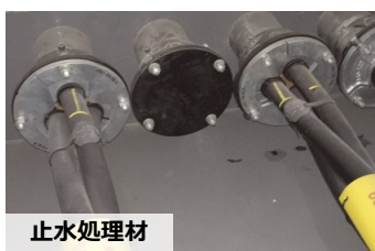
脱着型止水板
