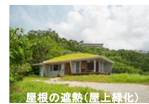
屋根の遮熱(屋上緑化)
