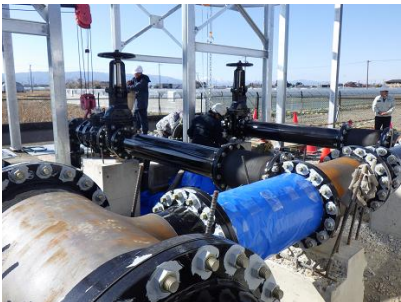
付属バルブ類据付（揚水機場）
