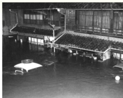
昭和58年9月洪水(戦後最大規模)美濃加茂市街の浸水状況
