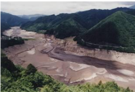
牧尾ダム(平成6年8月4日)
