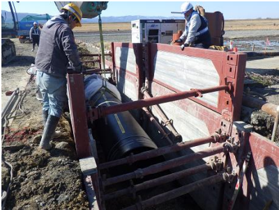
管据付状況（ダクタイル管）
