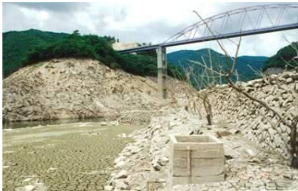
岩屋ダム(平成6年8月1日)
