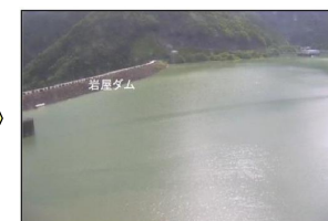
洪水時最高水位付近 (7月8日15時半頃)
