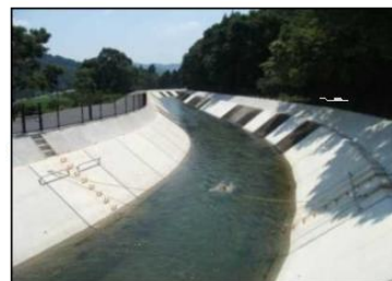
コンクリートライニング打換
