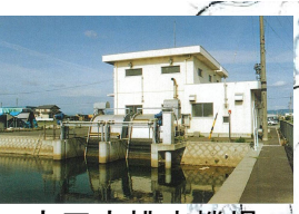
吉田方排水機場
