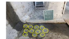
浄水場施設耐震補強 (せん断補強筋)
