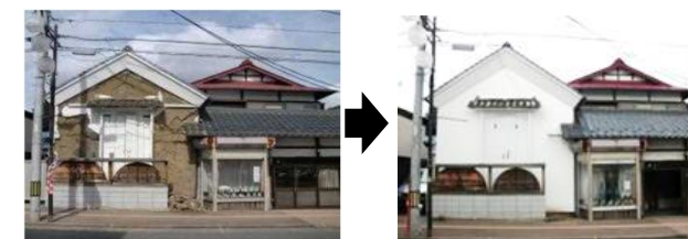
歴史的建造物の修復
