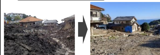
堆積した土砂の排除 (静岡県熱海市伊豆山地区)
