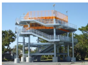
避難施設の整備
