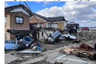
津波による浸水被害 (石川県珠洲市)
