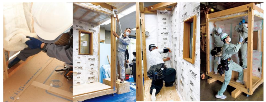
断熱施工実技研修会の様子
