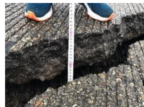
能登半島地震で発生した地盤変状に伴う滑走路の段差等 (能登空港)
