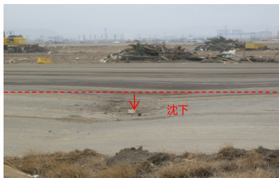
東日本大震災で発生した液状化による誘導路の沈下 (仙台空港)
