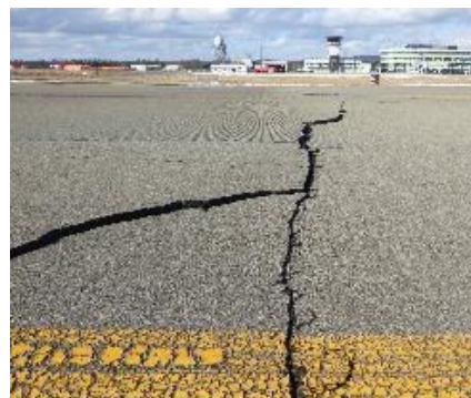
能登半島地震で発生した地盤変状に伴う滑走路の段差等 (能登空港)
