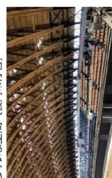
昆構造+免震構造によるフレキシブルな空間（長門市庁舎）
