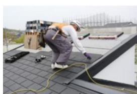
屋根の断熱化工事
