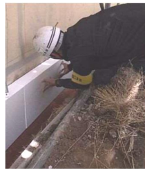
外壁の断熱化工事
