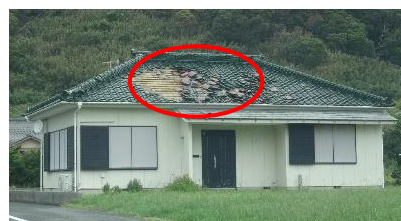
強風による屋根の被害(南房総市)
