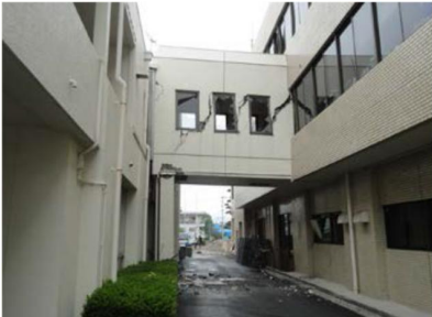
庁舎における構造部材の損傷
