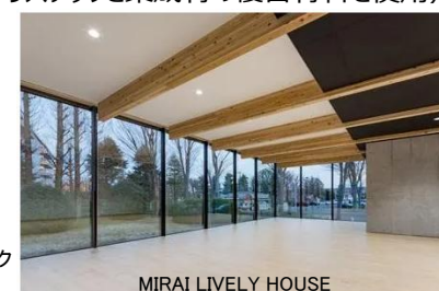
炭素繊維強化プラスチックと集成材の複合材料 (仮称) AFRW 1号物件 (MNNN-11173)
