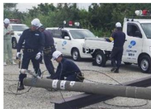
写真③ 倒壊電柱の除去訓練
