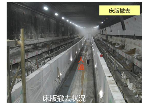
床版取替工事施工状況(H21)
