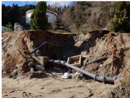
浄水場内の配管損傷(七尾市)
