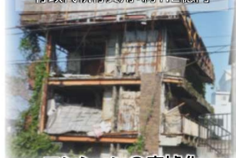
マンションの廃墟化 外壁が剥落し、アスベスト飛散のおそれ
