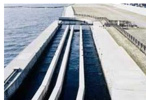
呼び水式魚道
