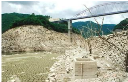
岩屋ダム(平成6年8月1日)
