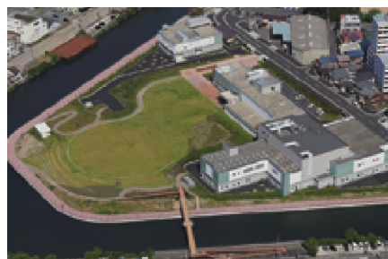
露橋水処理センター
