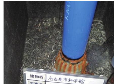
利用水槽の内部
