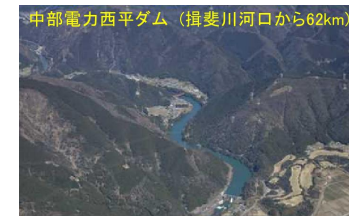
中部電力西平ダム（揖斐川河口から62km）
