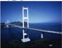
来島海峡大橋
