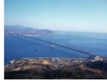
明石海峡大橋
