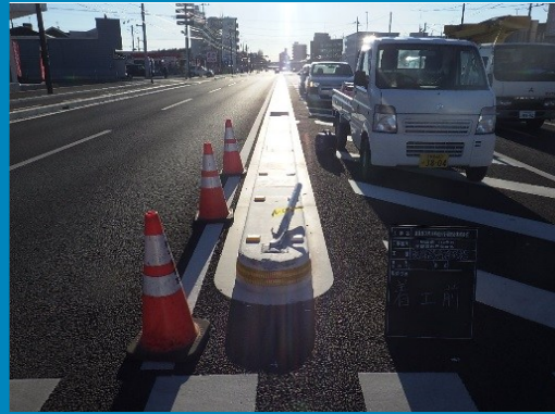
道路施設損傷等の緊急工事 (交通事故の処理)
