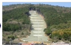
施工直後 (令和3(2021)年3月)
