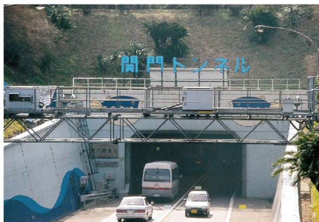
【関門トンネル】
