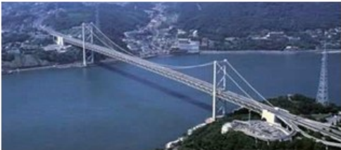
○関門橋の通行止め状況 (H27～R1年度)
