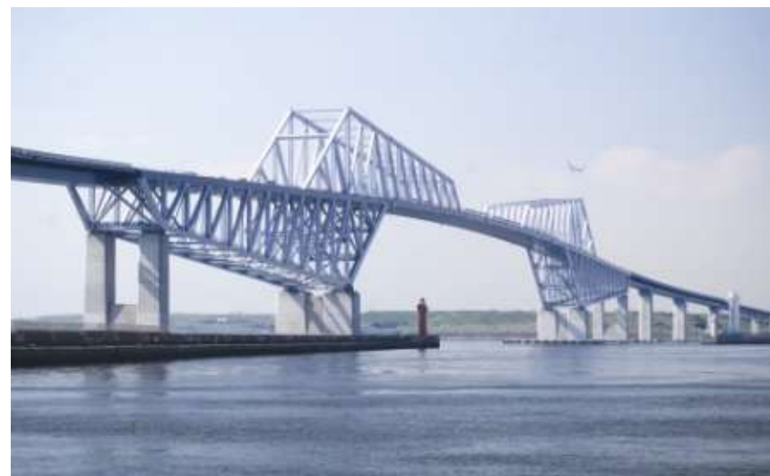
東京ゲートブリッジ(2012)
