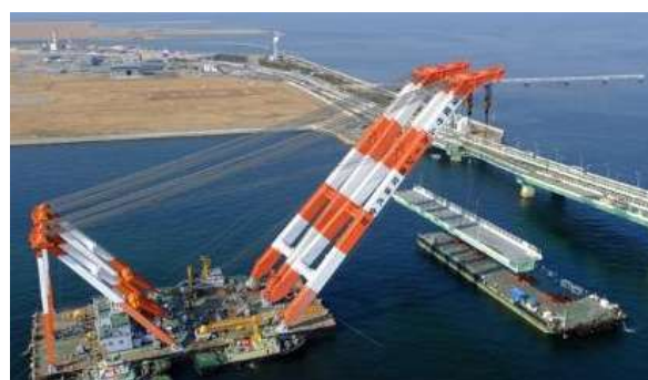
再製作したP1-P2の一括架設
