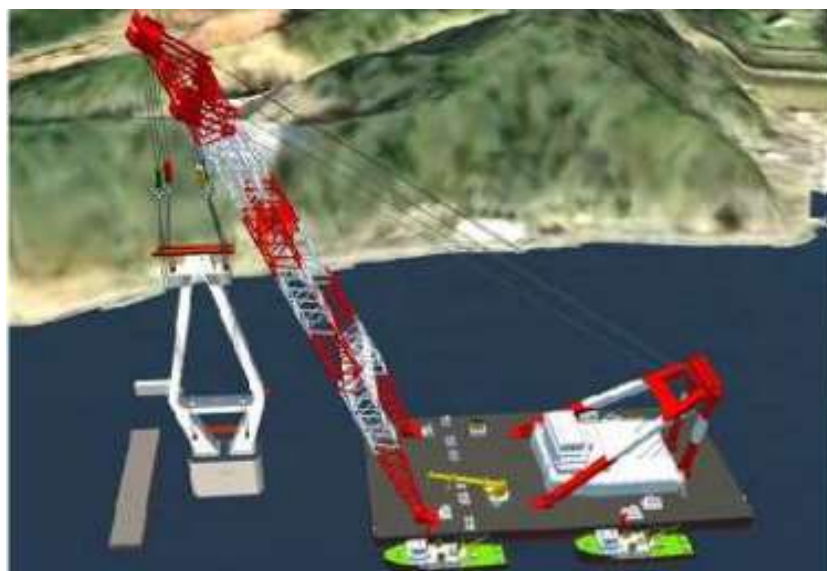
起重機船での架設 (漁業、船舶関係者への説明)
