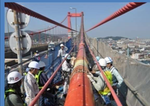
長大吊橋ケーブル補修の事例
