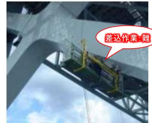
主塔斜材下面
