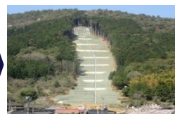
施工直後 (令和3(2021)年3月)
