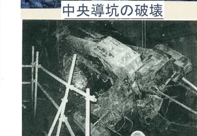
押出されたトンネル掘削機(TBM) 7
