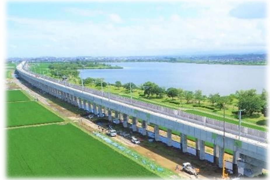
小松木場潟高架橋
