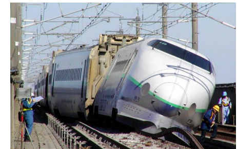
平成16(2004)年 新潟県中越地震 上越新幹線の被害状況
