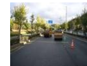
道路舗装(表層・基層)
