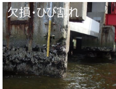
剥離・鉄筋露出
