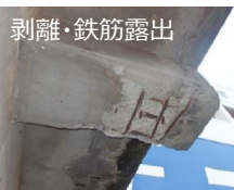
欠損・ひび割れ
