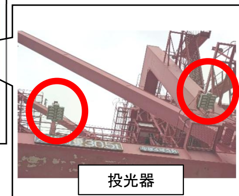
ガントリークレーン
