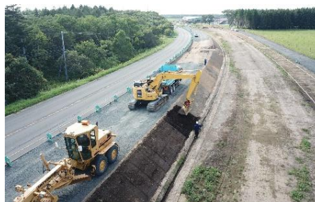
国道44号 根室防雪
