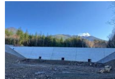
えん堤増厚工(十勝岳治山工事)
