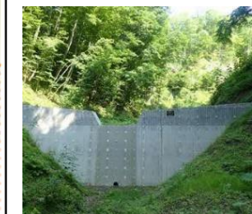
土砂流出を抑制し山地災害を防ぐ治山ダムの整備
