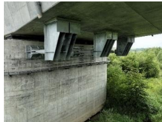
橋梁の耐震化の整備事例 (落橋防止装置)
