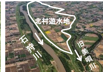
根幹的な治水対策として遊水地を整備
