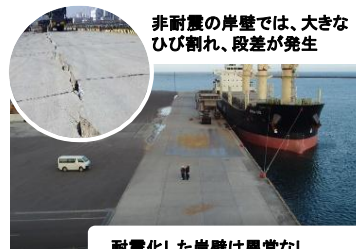
耐震強化した岸壁は異常なし
