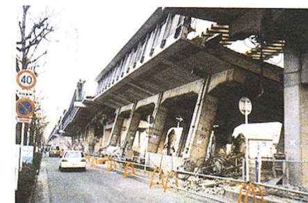
平成7(1995)年 兵庫県南部地震 山陽新幹線の被害状況
