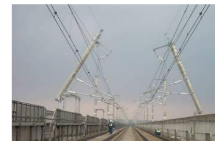
平成23(2011)年 東北地方太平洋沖地震 東北新幹線の被害状況
