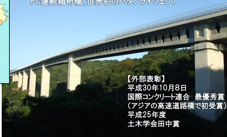
東九州自動車道 (寺迫ちょうちよ大橋) PC連続箱桁橋(世界初のバタフライウェブ)
