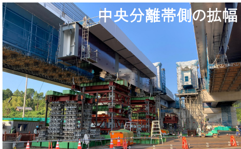
橋梁拡幅工事の概要
