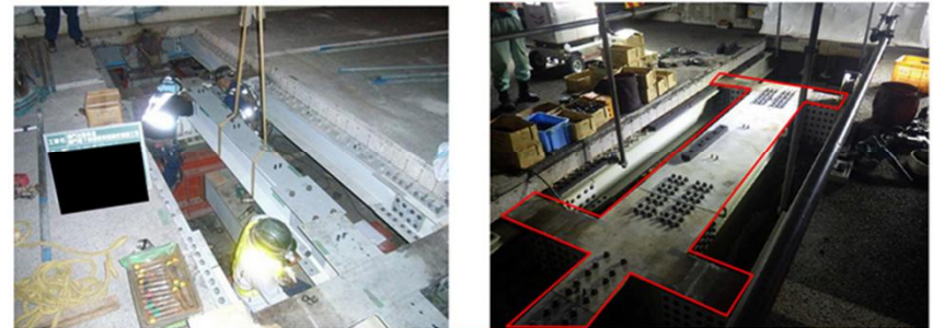
新設支承・横桁・縦桁の設置
