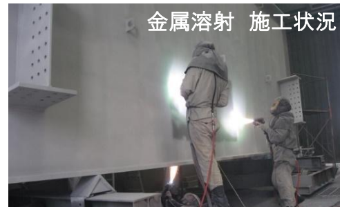
金属溶射の概要(プラズマアーク溶射)
